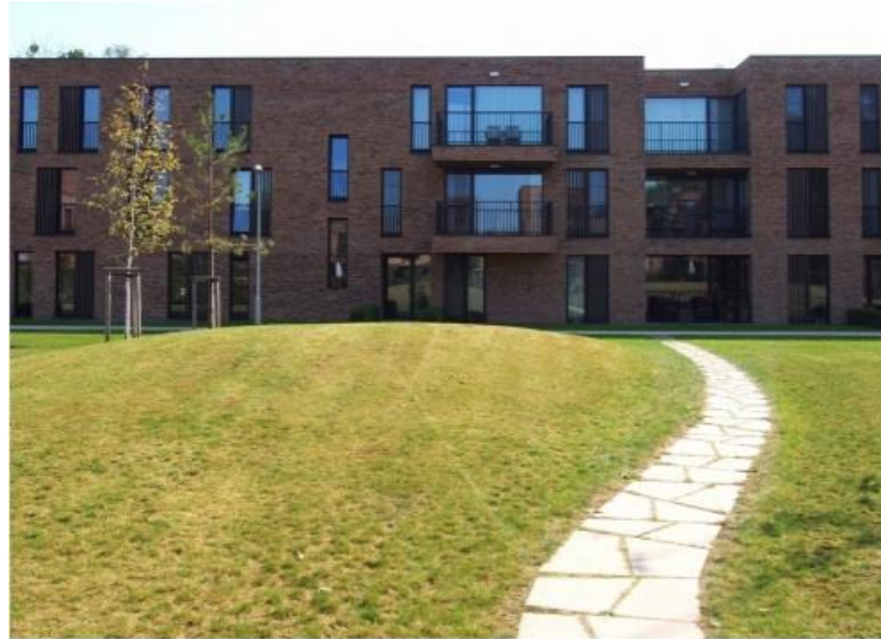
Horizontaal reliëf in de collectieve buitenruimte zet aan tot beweging - Catelijm Kapellen - Abscis Architecten
