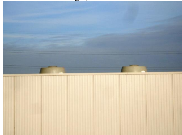
Ruimteventillatie (6 ventilatoren: 1x 2kW, 5x 6 kW) aardappelontvangst (AO)
