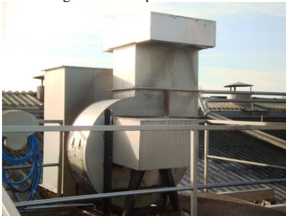
Bakdampontveter (ventilator na oven)
