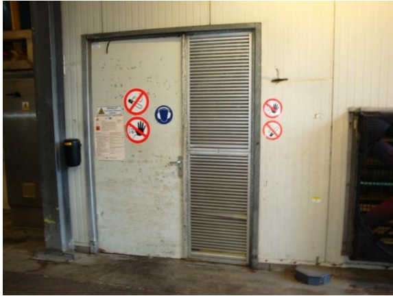
Verluchttingsrooster compressoruimte
