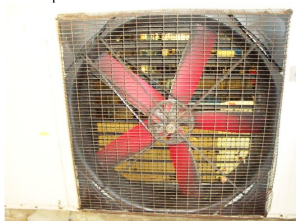
Schoepventilator compressoruimte
