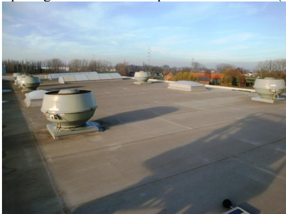
Ruimteventillatie (6 ventilatoren: 1x 2kW, 5x 6 kW) aardappelontvangst (AO)
