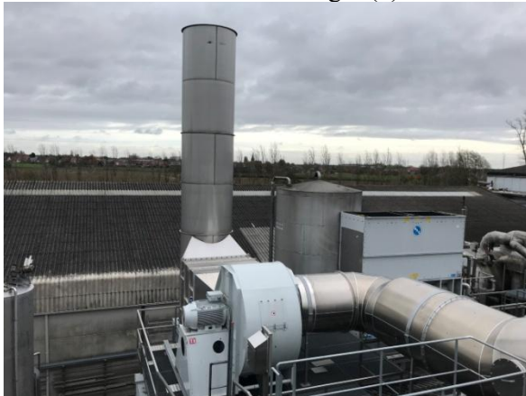
Centrale afzuigventilator
