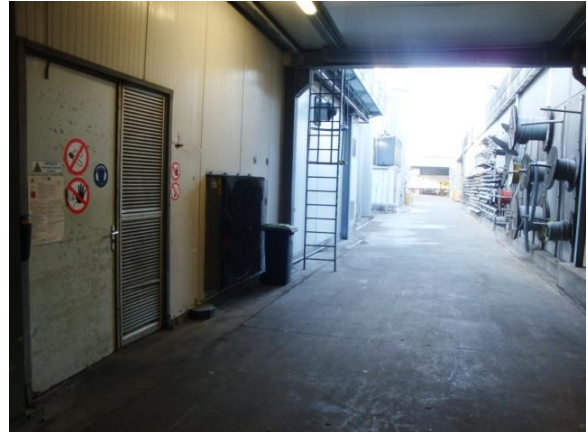
Gang met roosters compressoruimte (links)
